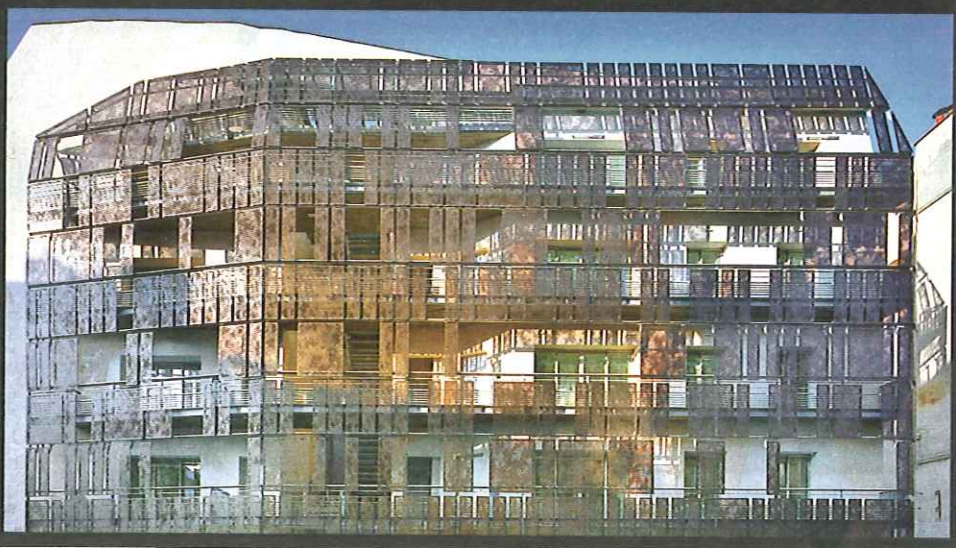
RÉNOVATION SPECTACULAIRE D'UNE FAÇADE LÉPREUSE.
